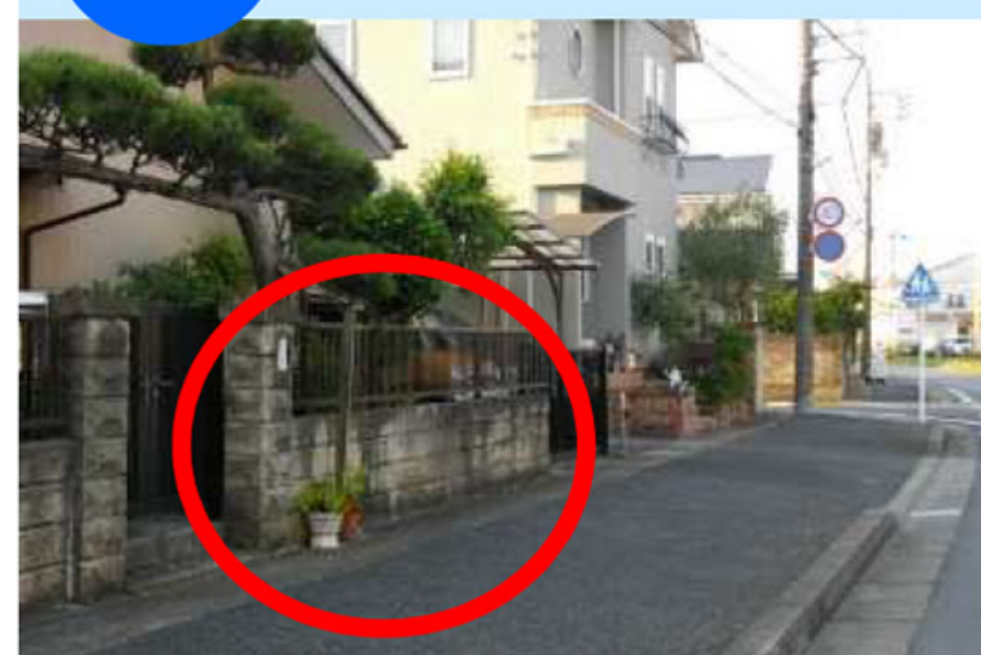
東武線アンダーパスより先150m
