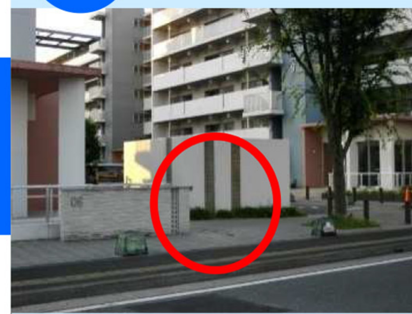
エンフォール6号棟玄関前
